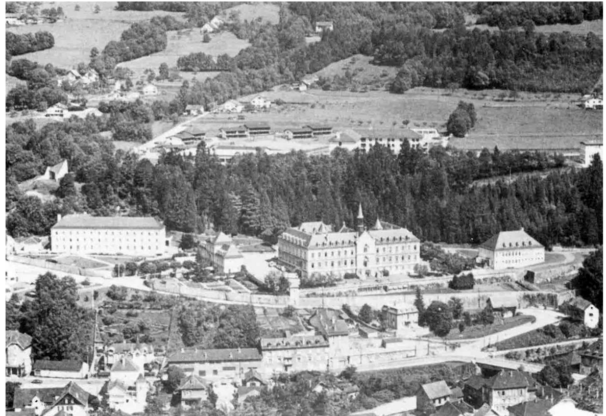
Construction de l'hôpital de 1880 à 1882
