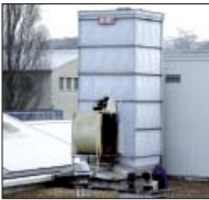
Les tours aéroréfrigérantes
