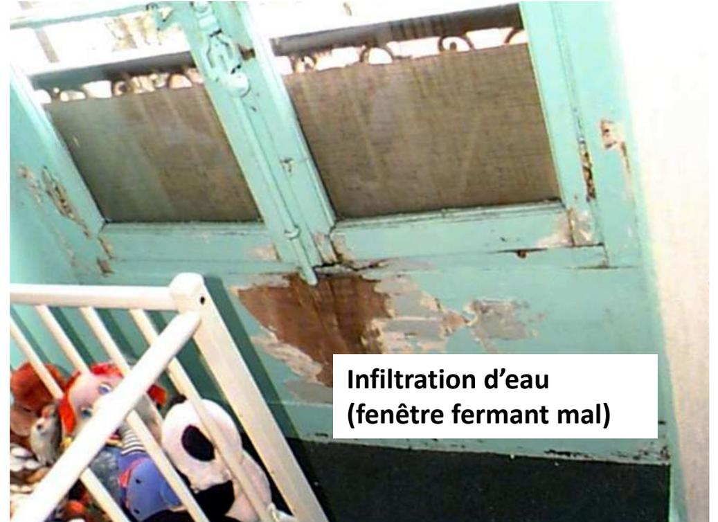
**Infiltration d'eau (fenêtre fermant mal)**
