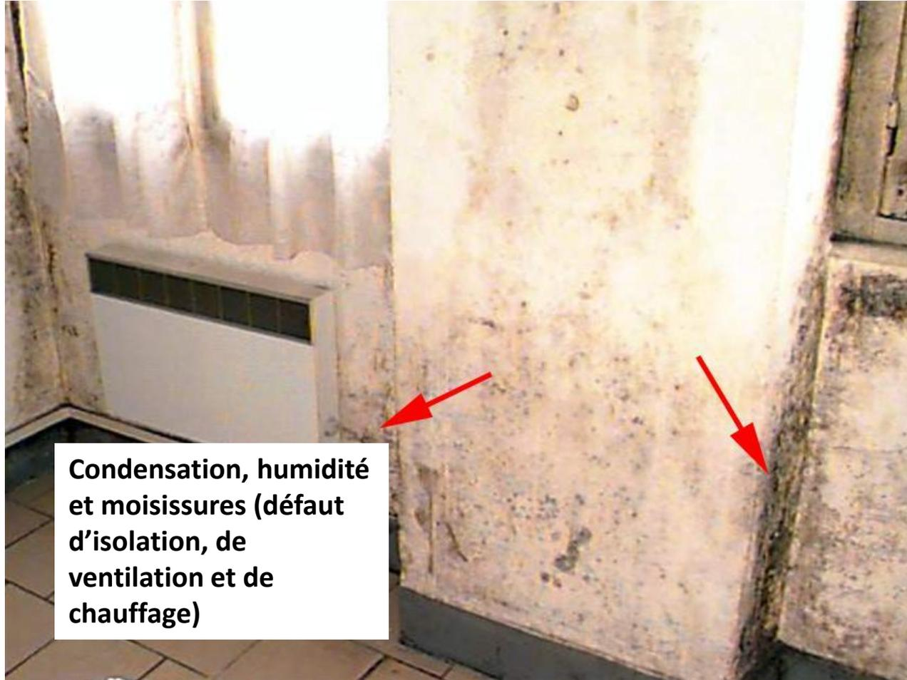
**Condensation, humidité et moisissures (défaut d'isolation, de ventilation et de chauffage)**
