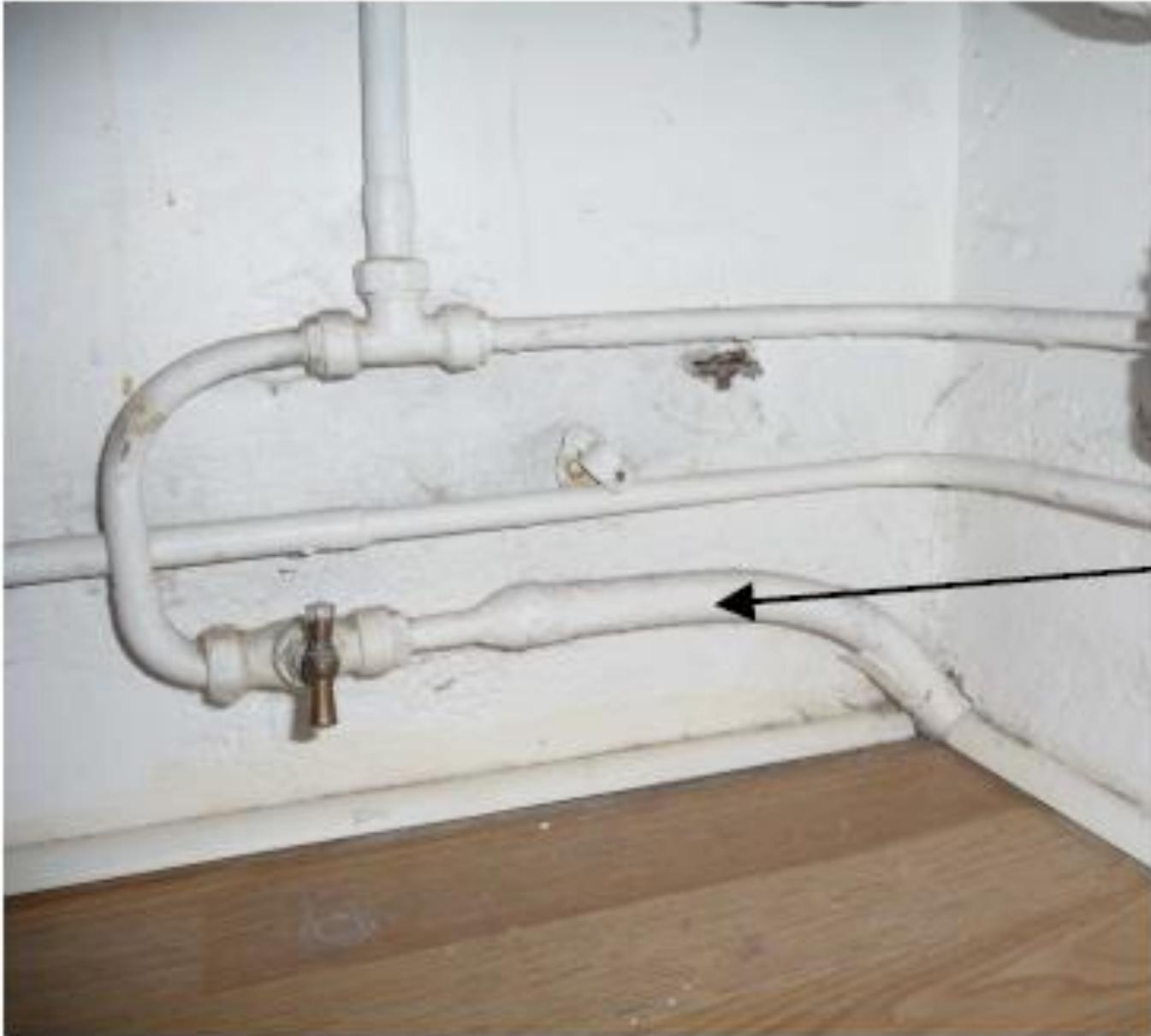
Arrivée d'une canalisation plomb dans un logement suivie par un réseau Cuivre (différence de diamètre)
