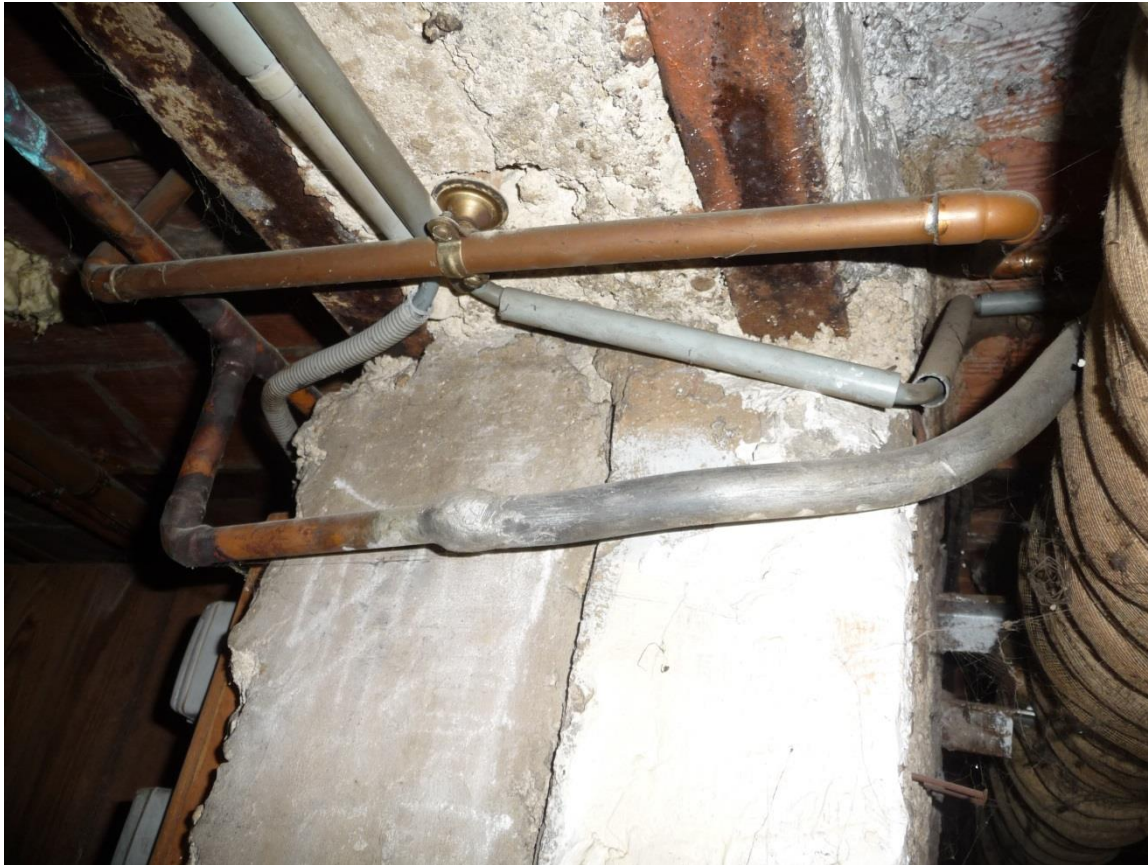
Plomb (gros diamètre et ductile) et Cuivre dans des caves
