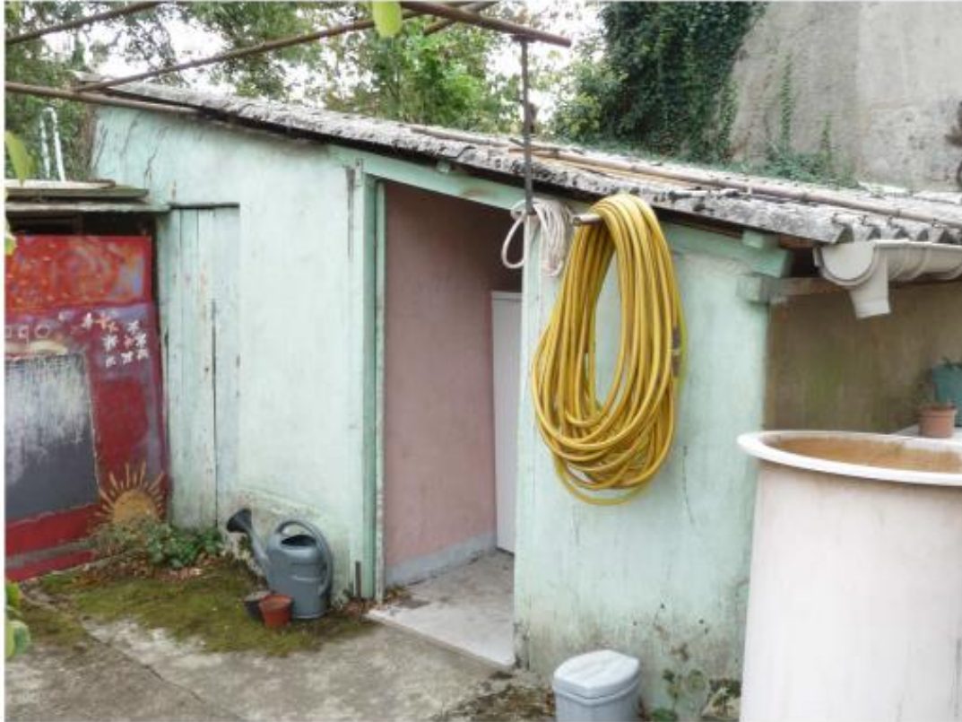
Cabanon recouvert de peinture verte contenant du plomb cabanon utilisé pour le stockage des vélos et jeux d'extérieur
